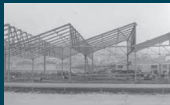
Construction du siège de Maxéville, 1962-63
