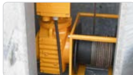
Moto-treuil fixe en pied de mât
