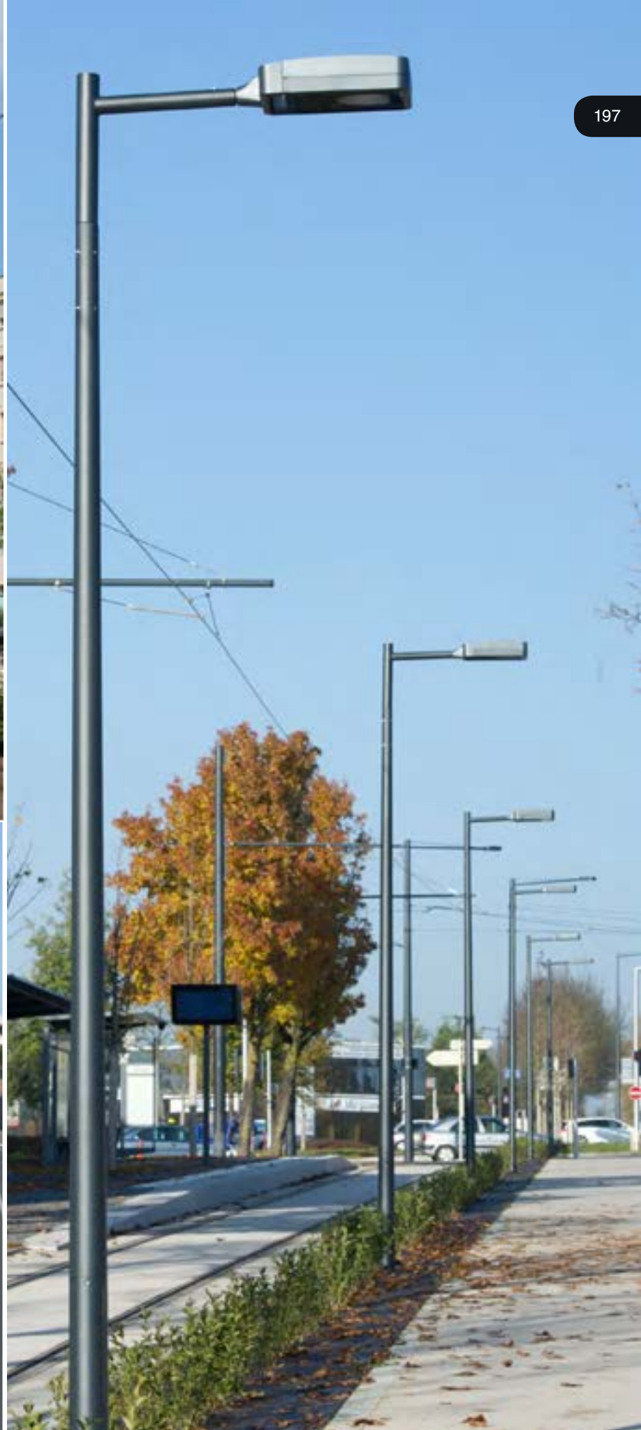
Éclairage et support de LAC. Design : Stoa Architecture - Alfred Peter.
