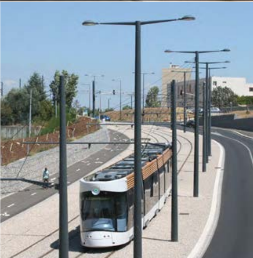
Éclairage et support de LAC. Design : Stoa Architecture.
